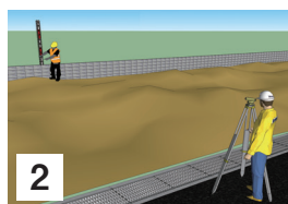
2 ブロック塀の高さを測る
